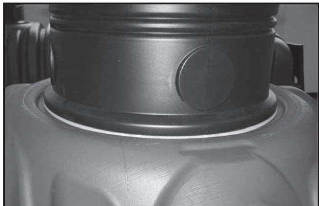
FIG.4 Install Riser
